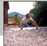
Typ AL: Wyrównywanie materiału.
