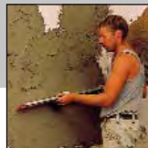
Typ TRK: Obciąganie obrutki.
