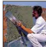
Typ HAK: Wygładzanie powierzchni obrutki.
