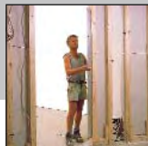
Typ AL 2L: Kontrolowanie stupa ściany.
