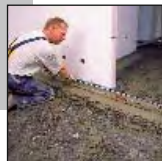
Typ AL 2L-2G: Wyrównywanie materiału jastrycha.
